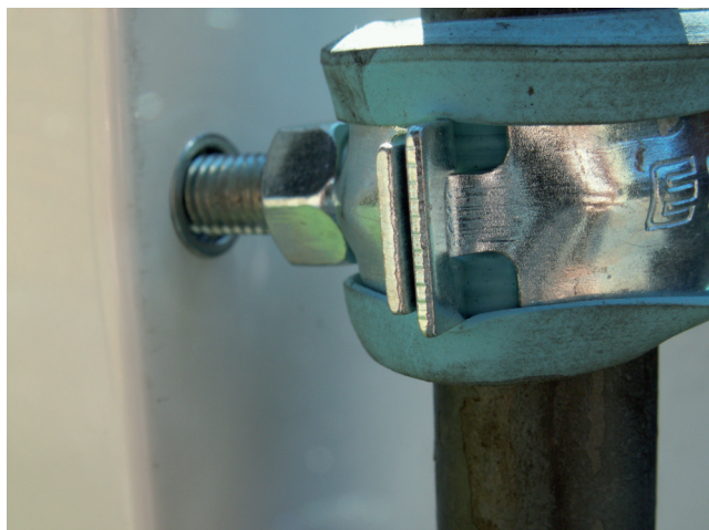
Närbild på infästning mot skåp.
